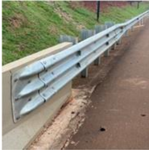
Figura 79 - Terminal Ancorado em Barreira de Concreto (TABC)
