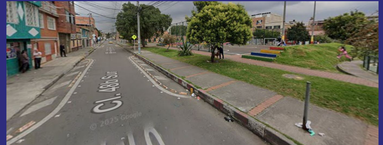
Figura 17 – Calle 48B Sur, em Bogotá, após as intervenções.
