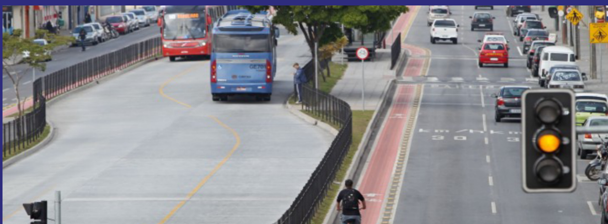
Figura 26 – Corredor de ônibus, com ciclovias e vias laterais com limite de 30 km/h em Curitiba.
