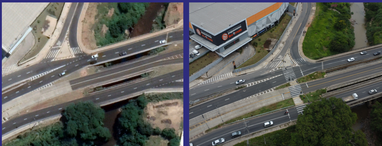
Figura 30 – Situação antes (esquerda) e situação depois das adequações (direita).
